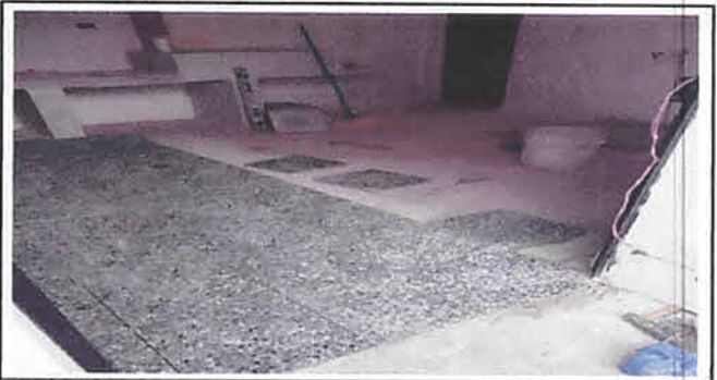
Foto 6: PISO DE GRANITO EN COCINA
