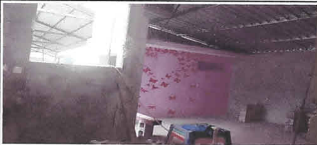
Foto 3: ENTECHADO DE ESTRUCTURA METALICA EN COCINA
