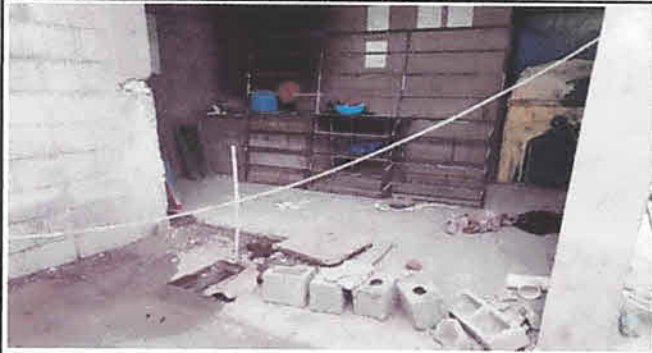
Foto 1: DEMOLICION DE PARED Y VENTANA
