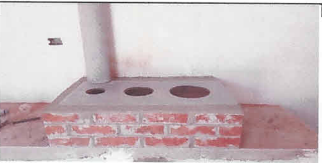
Foto 5: CONSTRUCCION DE ESTUFA CON PLANCHA
