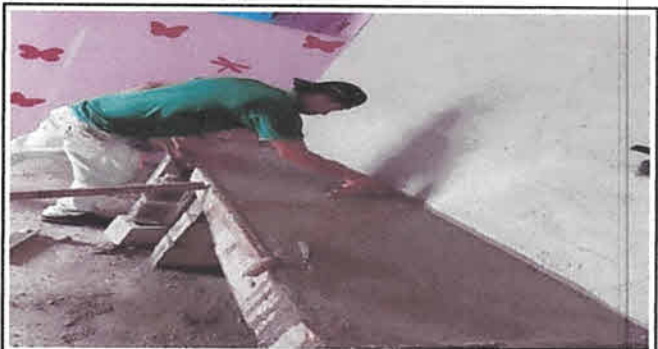
Foto 4: CONSTRUCCION DE POLLETON
