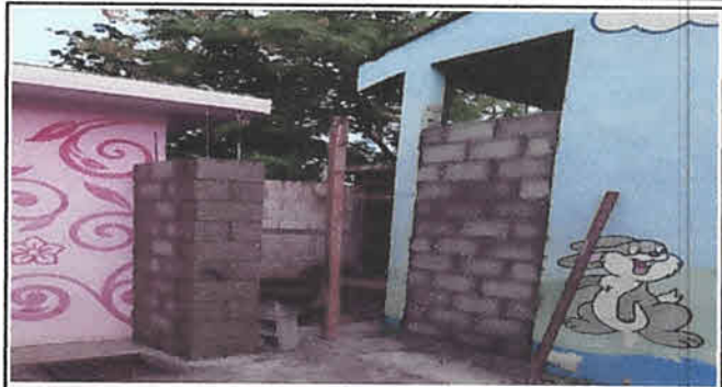
Foto 2: LEVANTADO ESQUINA DE MURO
